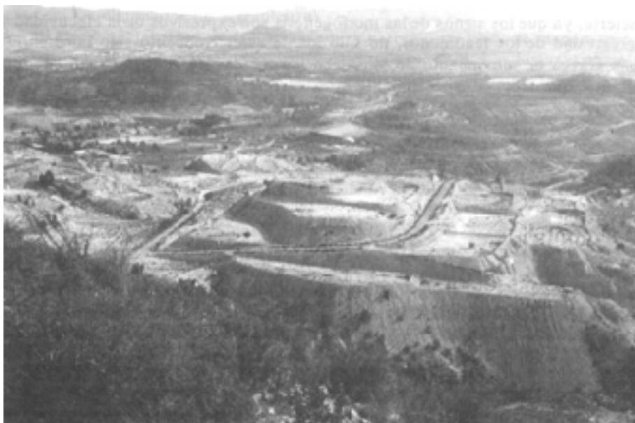
*El trazado de una carretera aprovechando el fondo plano del barranco produjo cuantiosos daños en La Zenia (Orihuela), con motivo de un chubasco de elevada intensidad.*
